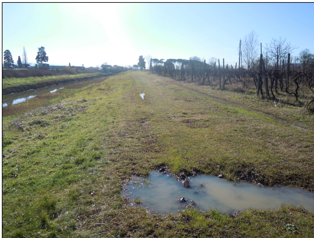
Figura 5.2 - Vista del Canale scolmatore e dell'area pianeggiante alla sua destra idraulica
